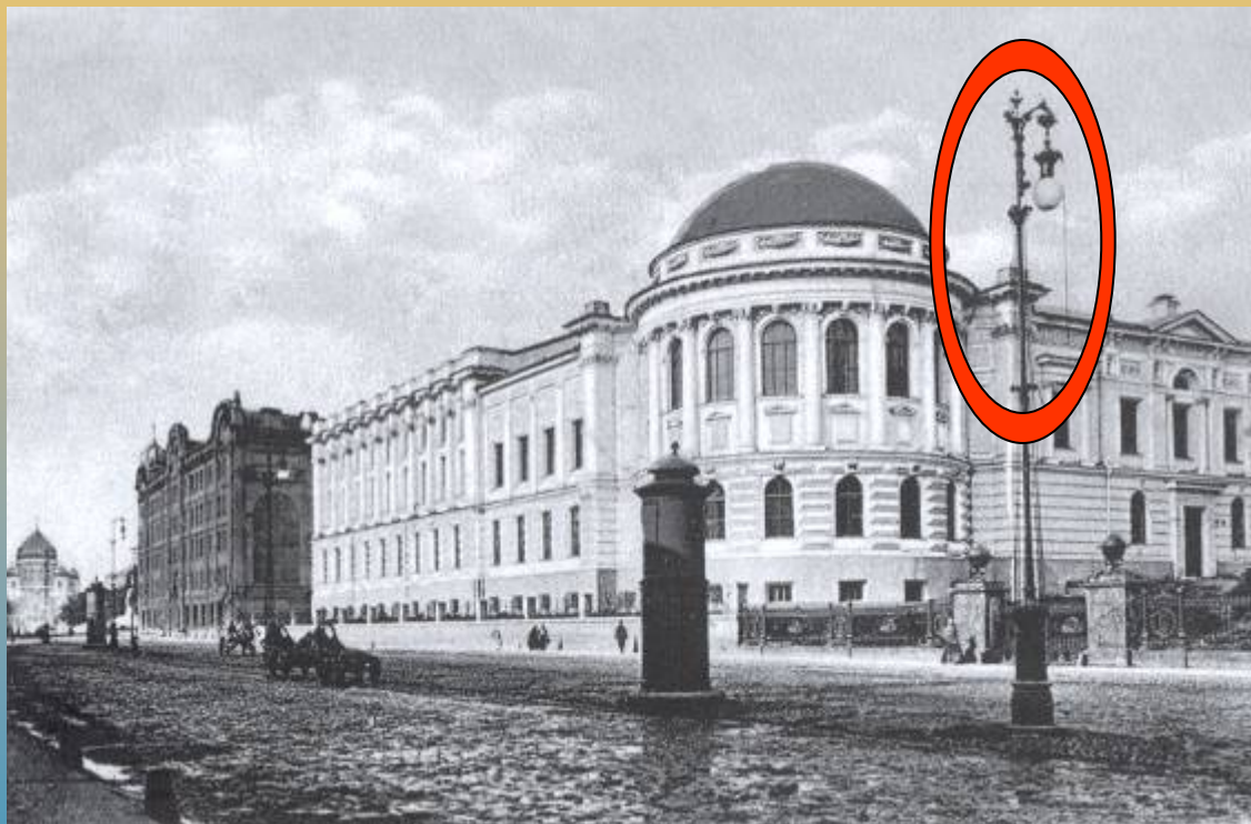
Электрический дуговой фонарь возле здания МГУ
